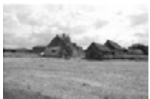
Vue d'ensemble depuis l'ouest : le logis-étable, l'étable-porcherie, la remise.
