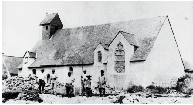
et une place déjà en travaux.
