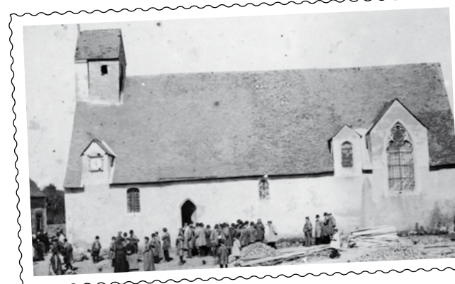
Déjà des travaux sur la place à Blandouet vers 1894
