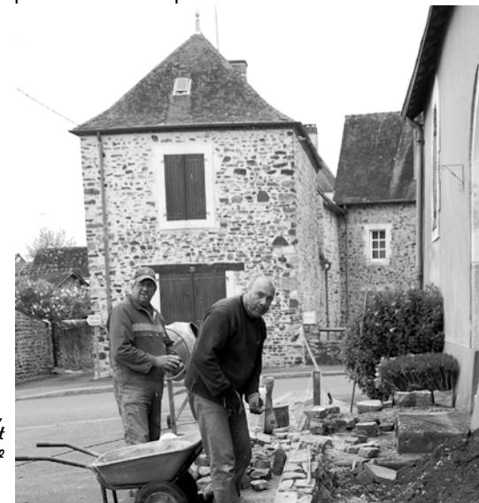
Mai 2013, des bénévoles construisent une rampe d'accès à l'église
